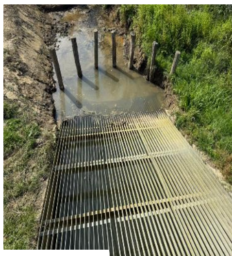
Dégrillage bassin Harriague MOUGUERRE
