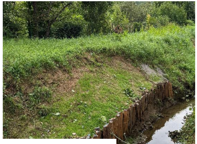
Confortement remblais sur lit majeur URCUIT
