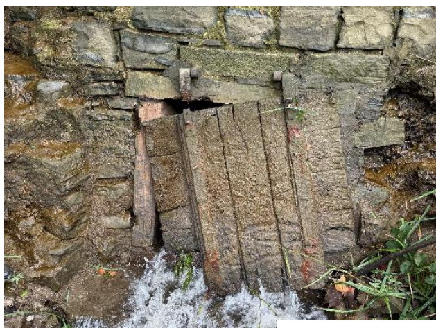
Réparation clapet BAYONNE
