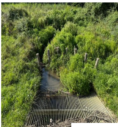
Dégrillage bassin Harriague MOUGUERRE
