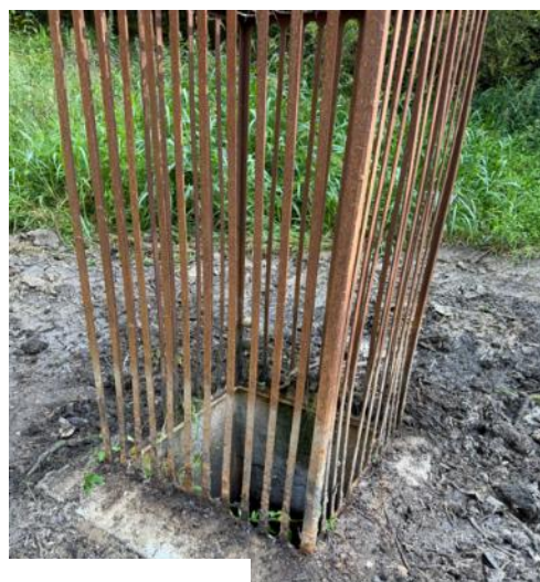
Dégrillage bassin Ecureuil MOUGUERRE
