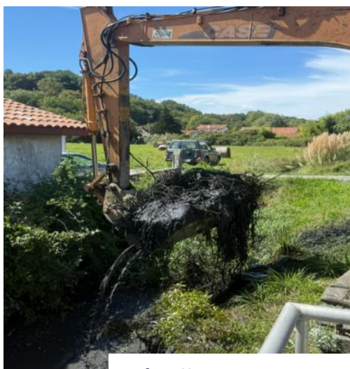
Dégrillage amont poste des Barthes Neuves MOUGUERRE
