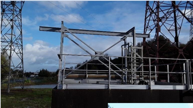
Mise en place d'un portique pour l'entretien des pompes (bassin RTE)
