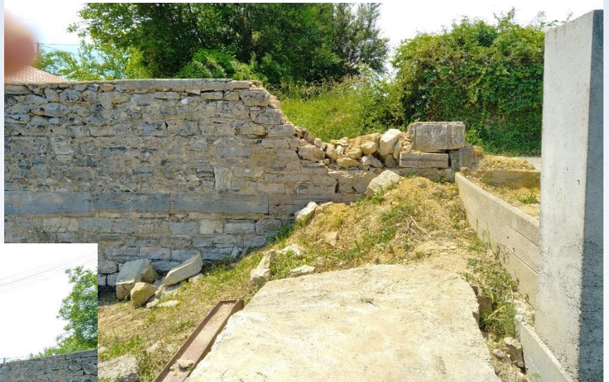
Jointage mur/digue de « Horgave » à SAINTE-MARIE DE GOSSE
