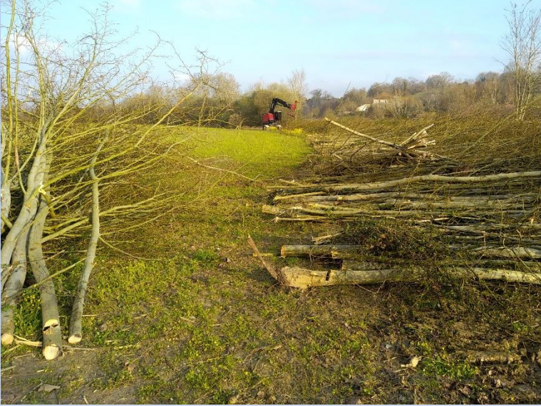
Débroussaillage des talus de digue à BIDACHE
