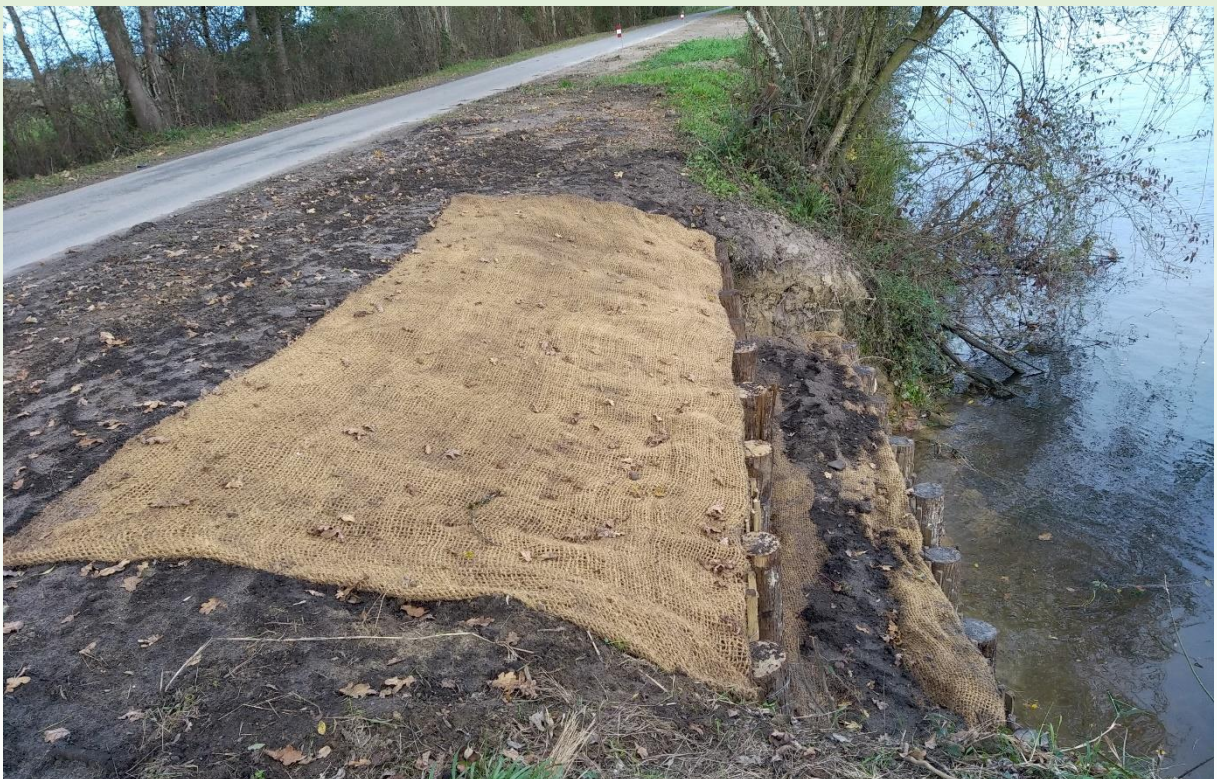
Reprise d'un affaissement de berge à SAINT-GEOURS DE MAREMNE
