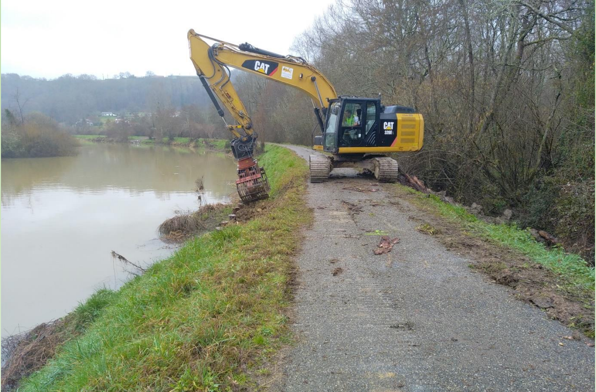
Reprise d'un affaissement de berge à GUICHE
