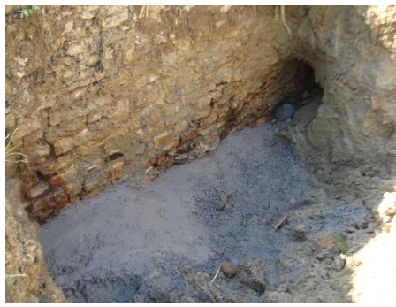
Traitement d'un « renard » autour d'un ouvrage hydraulique
